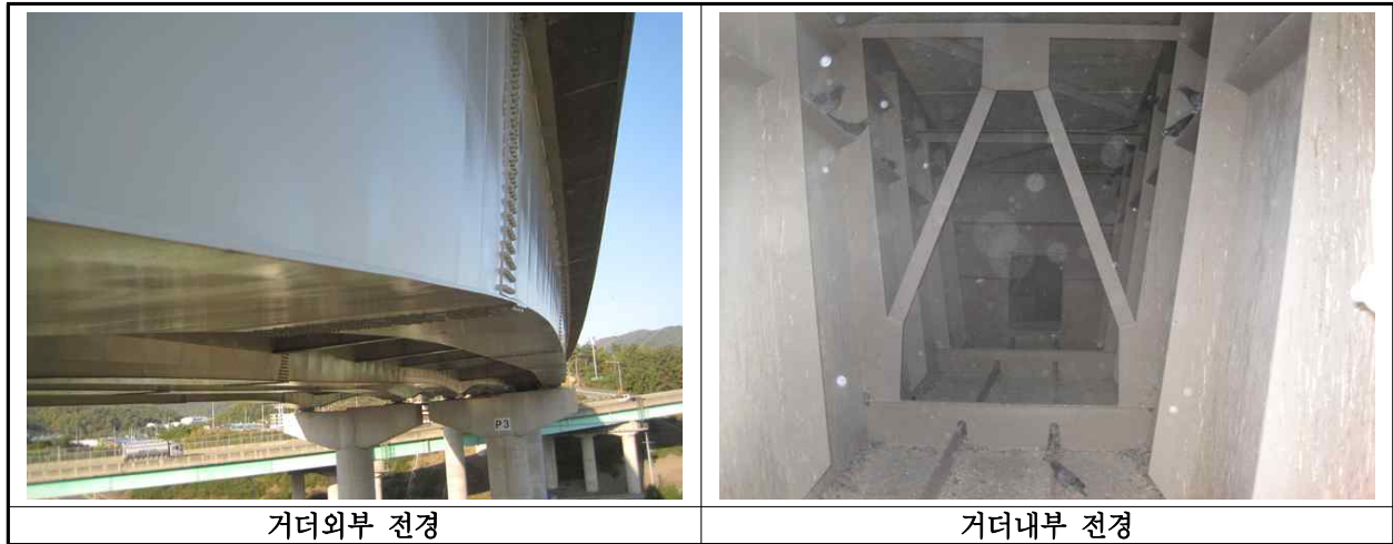
【사진 40.3.4】 거더 전경
