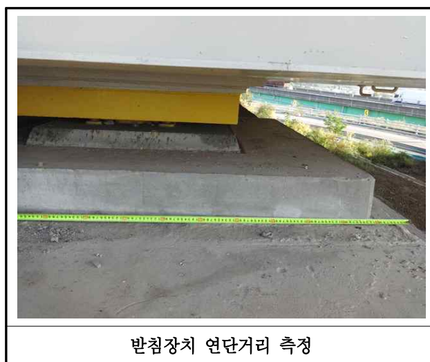
【사진 40.3.12】 교량받침장치 연단거리측정
