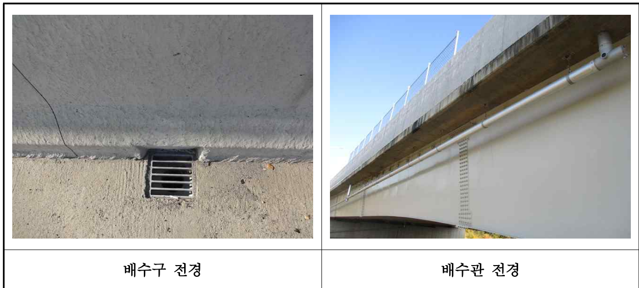
【사진 40.3.41】 배수시설 전경
