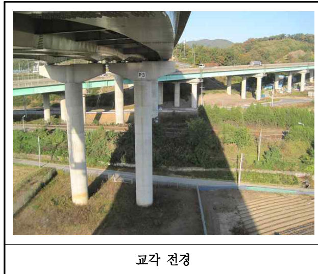
【사진 40.3.8】 교각 전경
