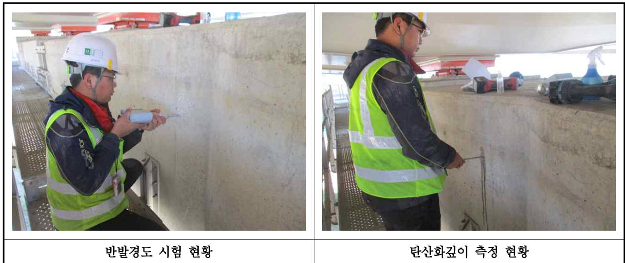
【사진 40.4.1】 콘크리트 내구성조사 현황
