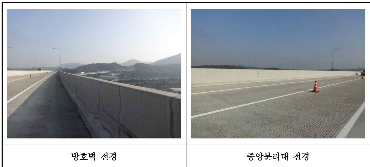
【사진 40.3.42】 방호벽 및 중앙분리대 전경
