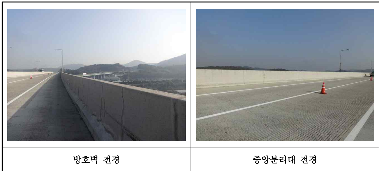
【사진 40.3.20】 방호벽 및 중앙분리대 전경
