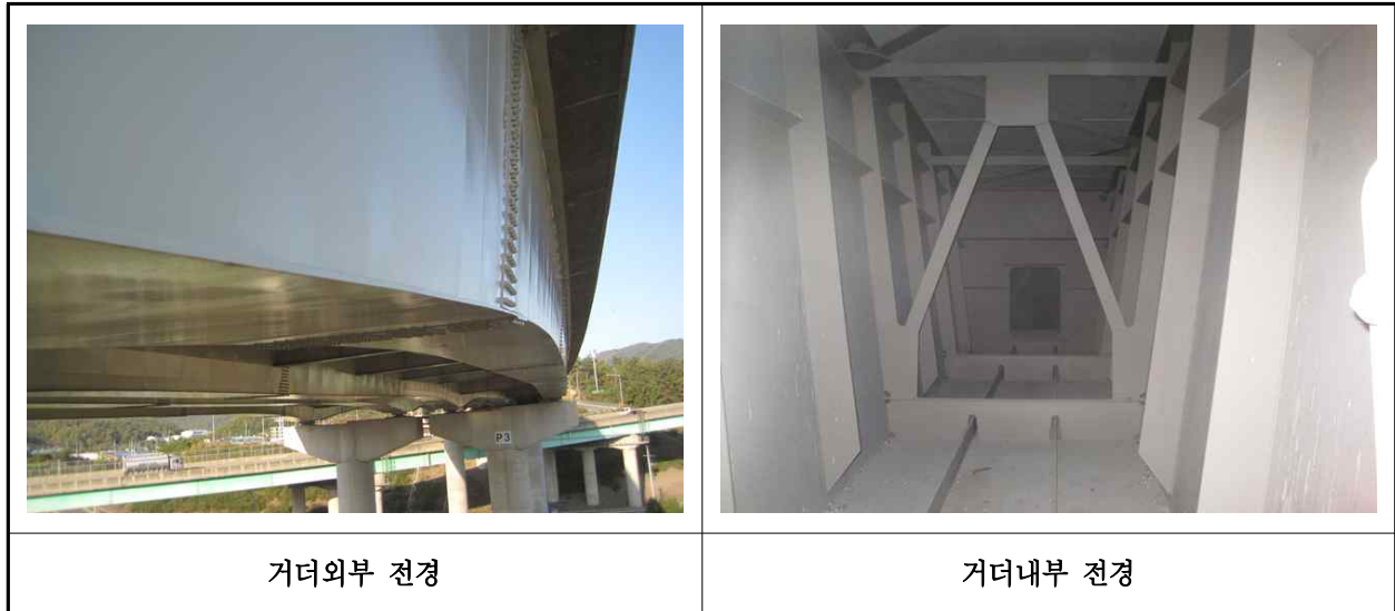
【사진 40.3.25】 거더 전경
