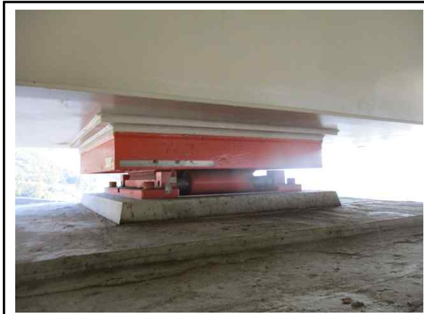
교량 받침 이동량 상태
