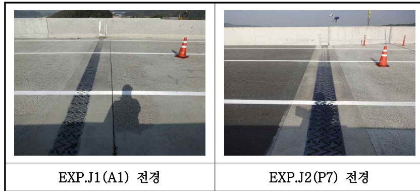
【사진 40.3.14】 신축이음장치 전경
