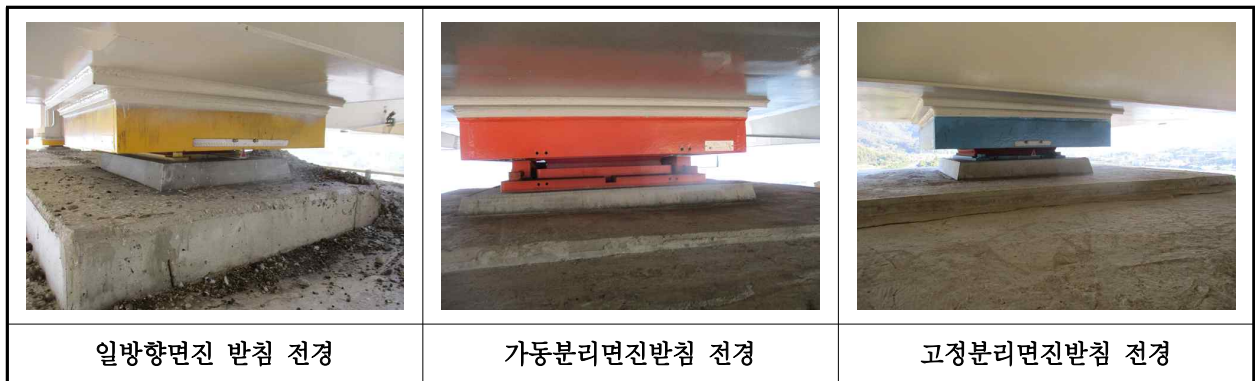
【사진 40.3.32】 교량받침 전경
