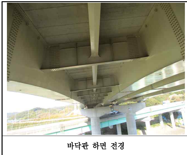
【사진 40.3.24】바닥판하면 전경
