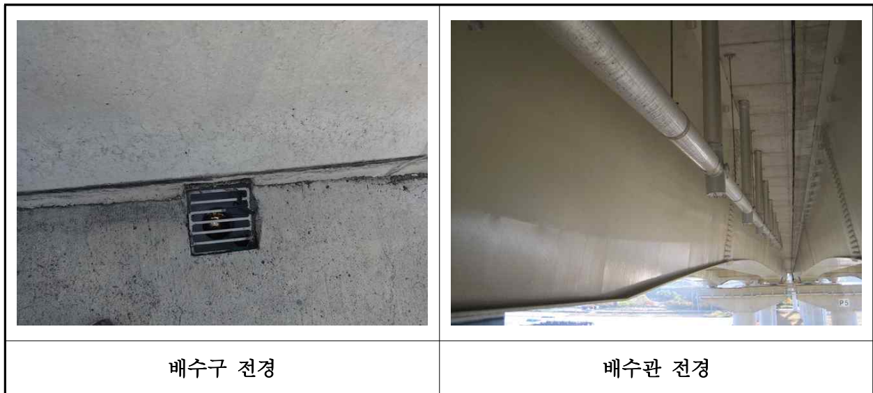
【사진 40.3.19】 배수시설 전경
