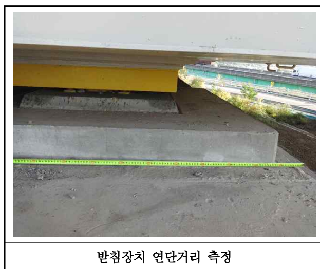
【사진 40.3.34】 교량받침장치 연단거리측정
