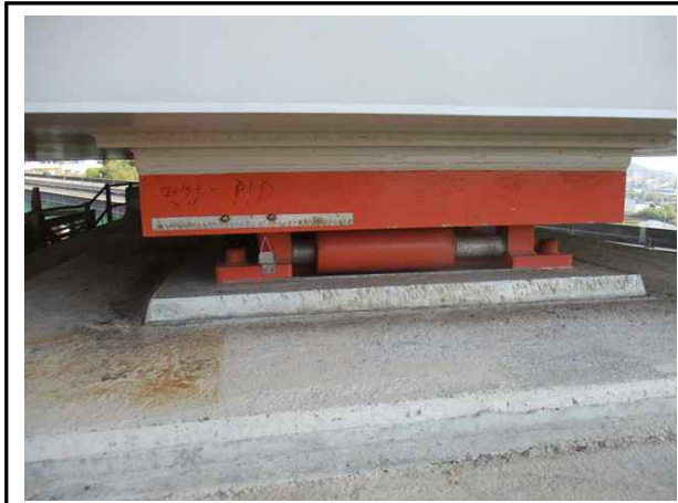
교량 받침 이동량 상태
